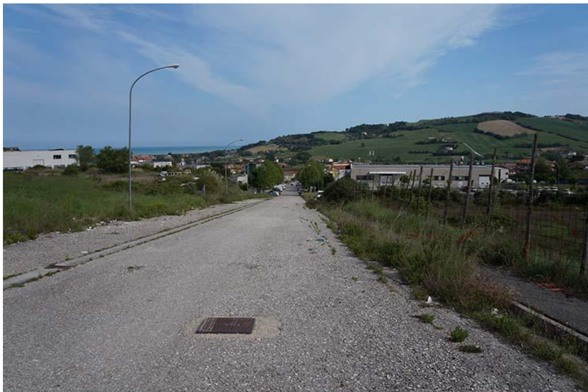
VISTA SUD OVEST - via C. ONESTI
