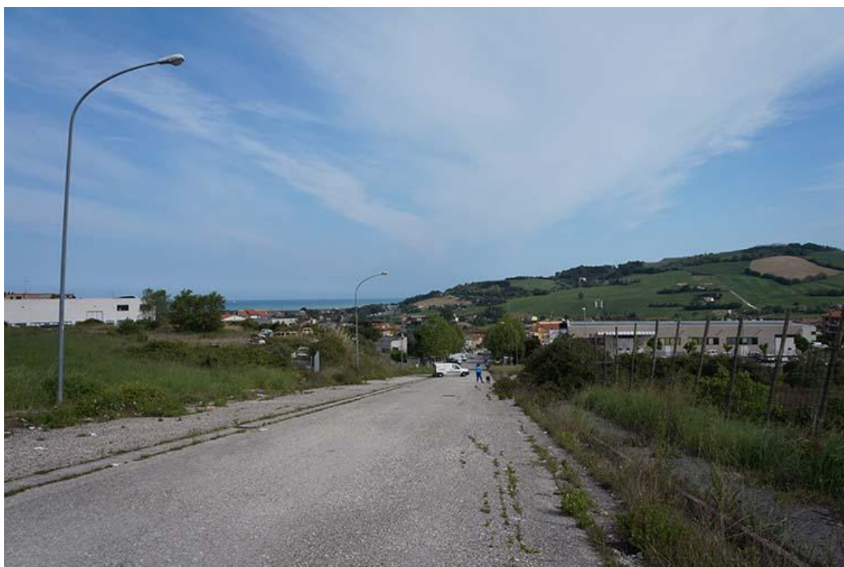
VISTA SUD OVEST - via C. ONESTI
