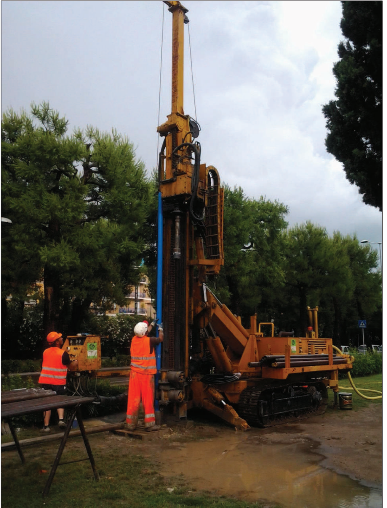
Postazione sondaggio geognostico S8 – 261+328
