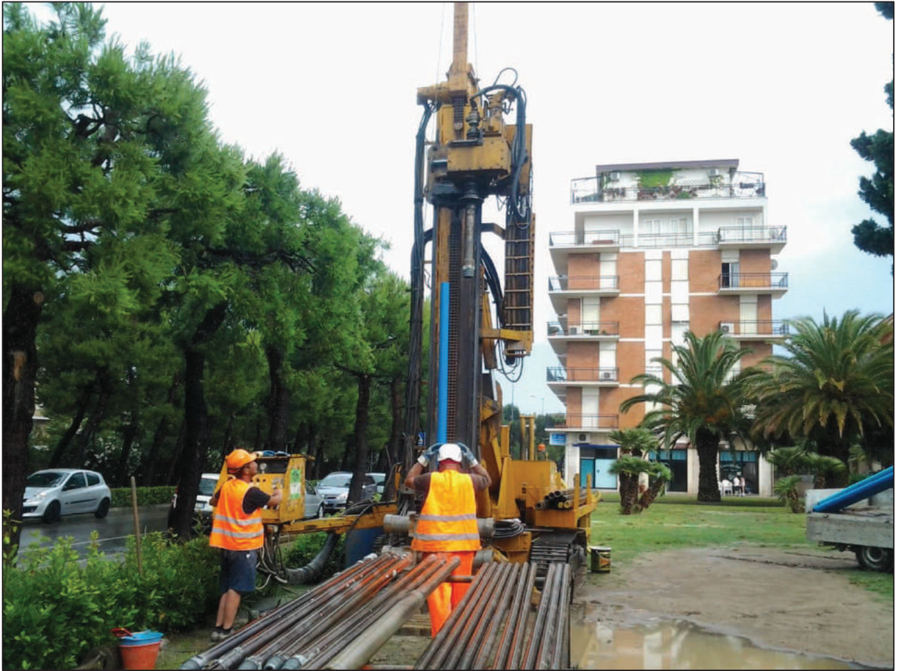
Postazione sondaggio geognostico S8 – 261+328
