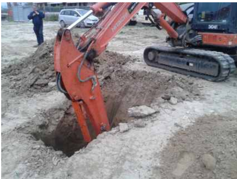
Foto 1 : Fasi esecutive dello scavo Sc1
