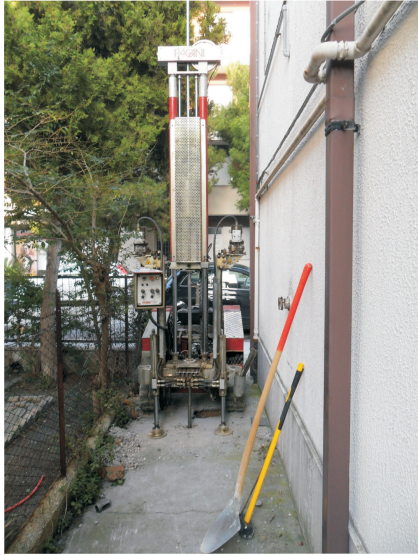
foto 1: esecuzione prova penetrometrica dinamica super-pesante Dpsh2
