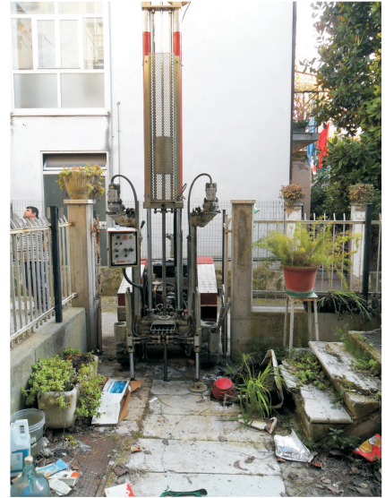
foto 2: esecuzione prova penetrometrica dinamica super-pesante Dpsh1
