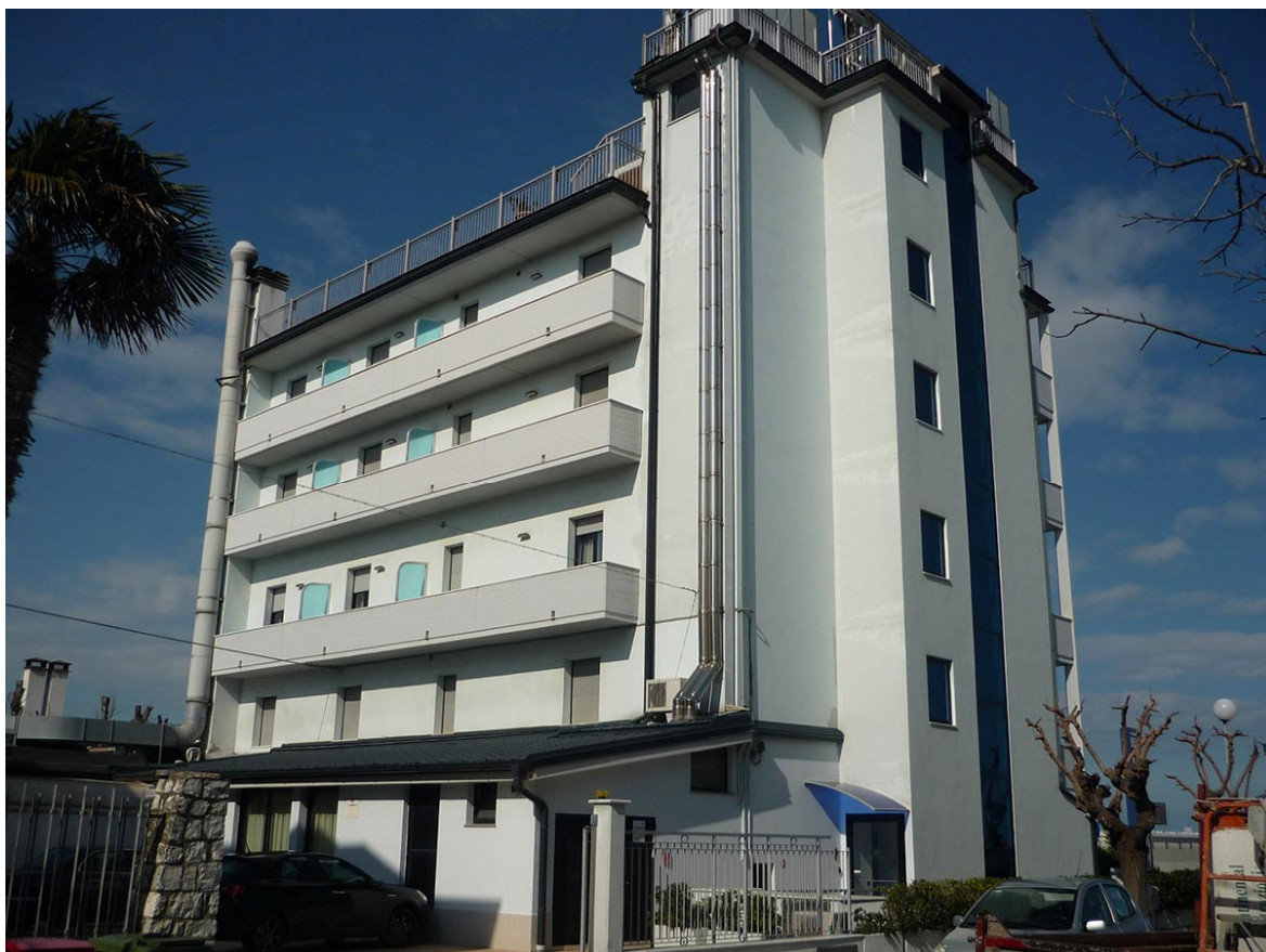
VISTA SUD - OVEST
