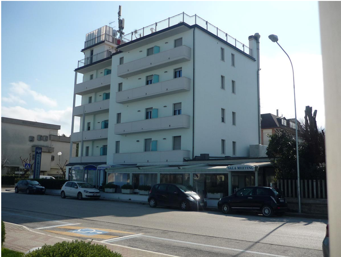
VISTA NORD EST
