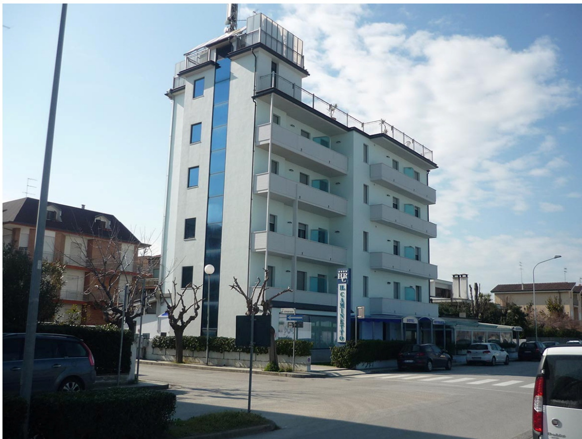
VISTA SUD - EST
