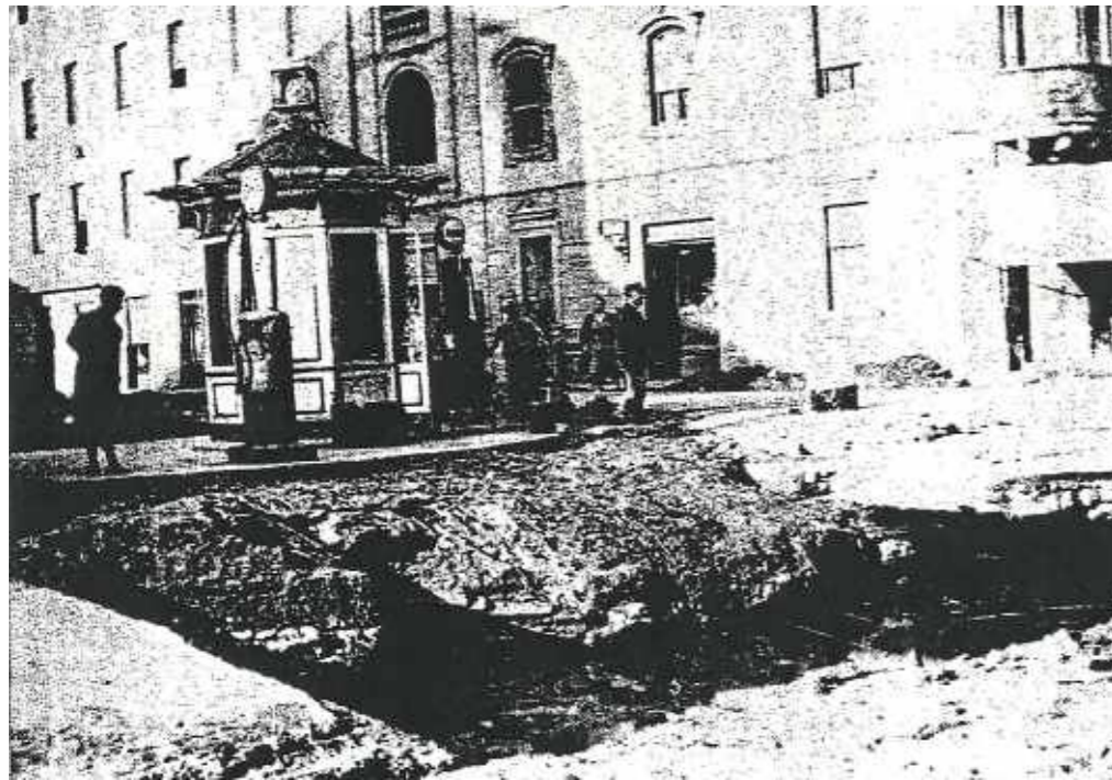
Fotogramma, reperito dagli archivi comunali, del cedimento della volta della porzione in galleria nei pressi de Piazza San Giorgio. Evento alluvionale 7/8 settembre 1947
